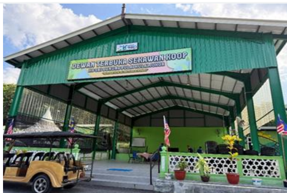
Membina Dewan Terbuka, Kampung Sri Gunung Pulai, Kulai, Johor
